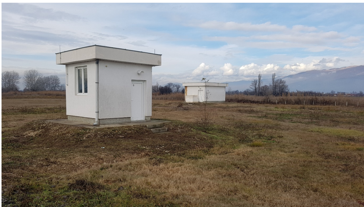
Сл.4. Пумпна станица ТИРЗ - н.Илинден
