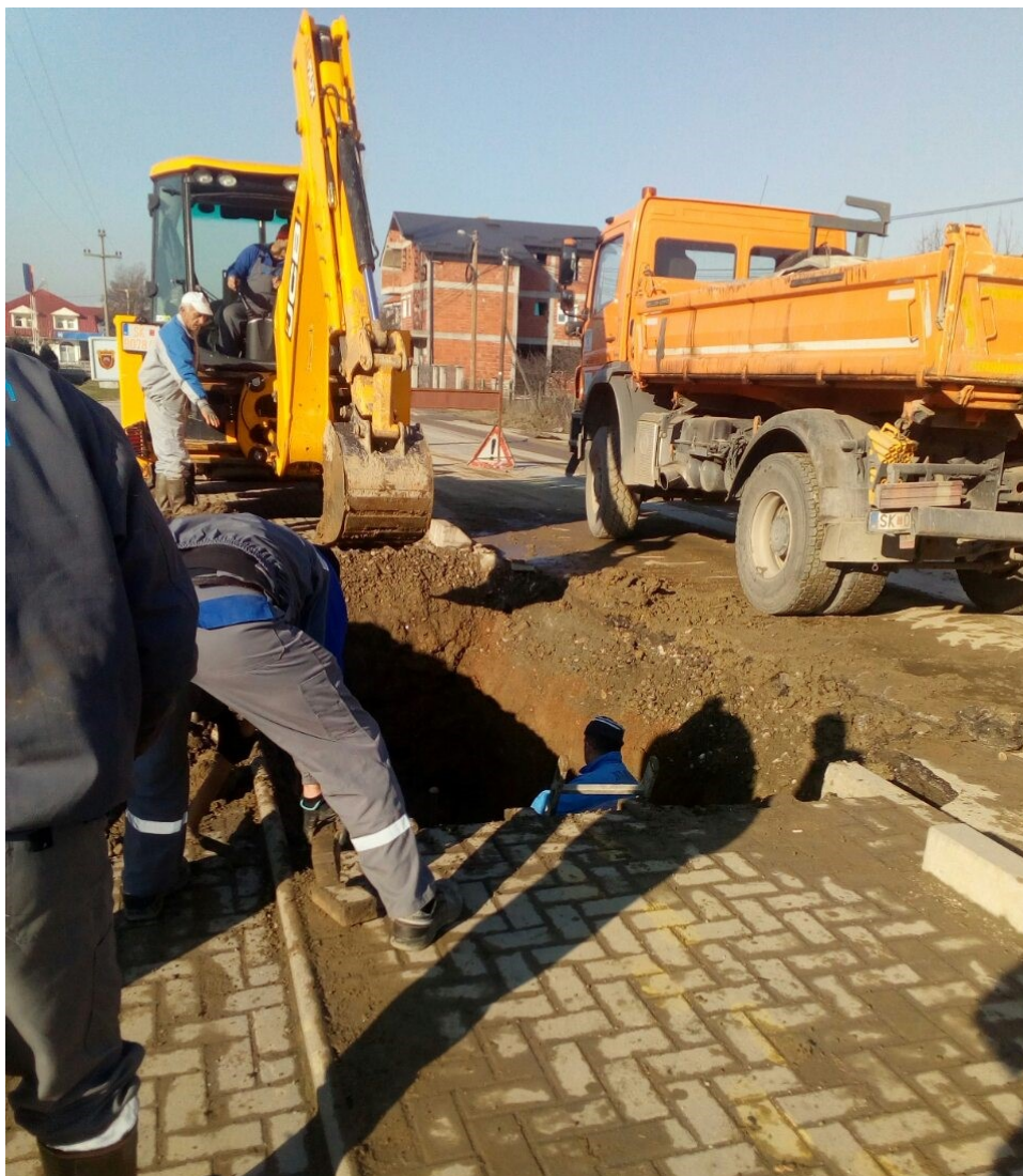
Сл.2. Санација на дефект на водоводна линија
